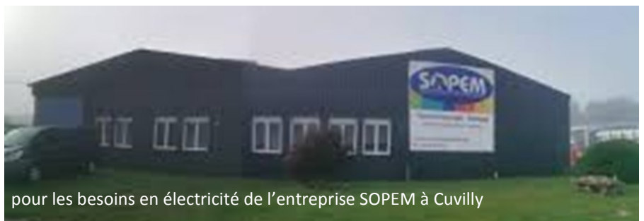
Installation de panneaux photovoltaïques
